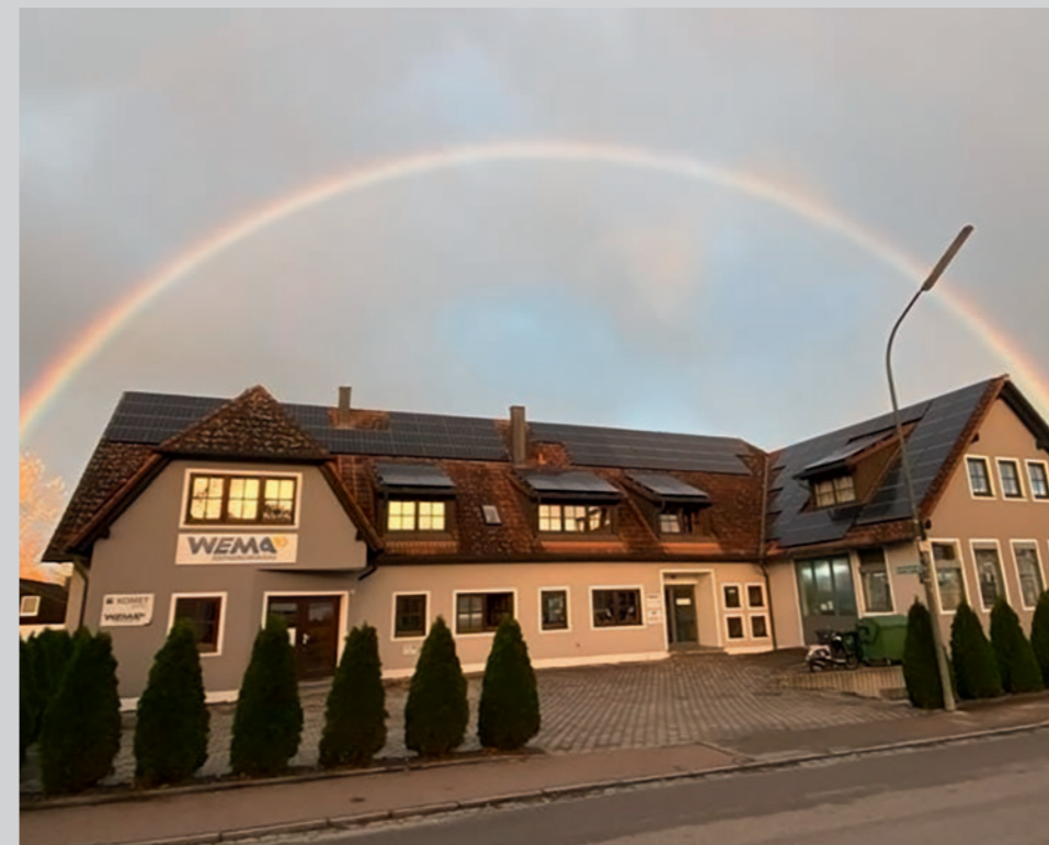
Company headquarters of WEMA Zerspanungswerkzeuge GmbH in Pfaffenhofen.
